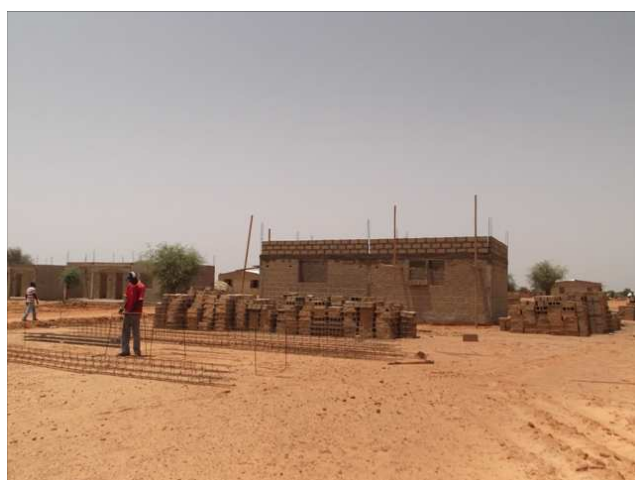
Les chantiers du CSCOM et Centre Multifonctionnel des jeunes et des Femmes de Sabalibougou en cours de réalisation par le PAPAM
