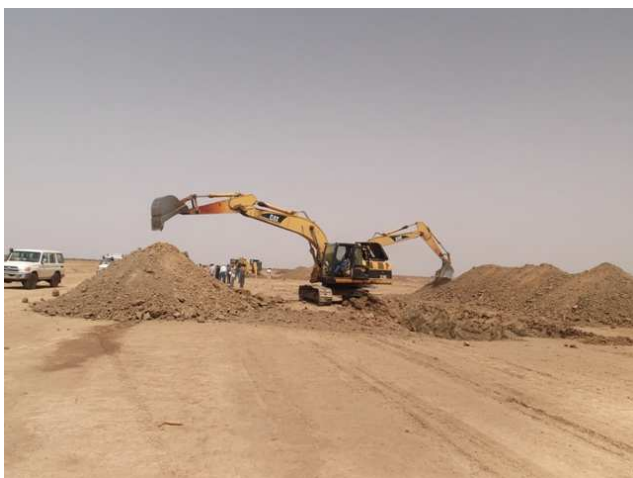
Visite des chantiers de Sabalibougou
