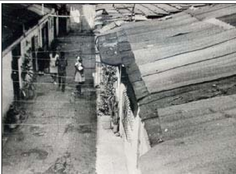
Ciudadela Calle Espada 411, antes de la renovación.
